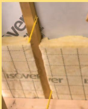
Mise en place de la 1<sup>re</sup> couche d'isolant Isoconfort
